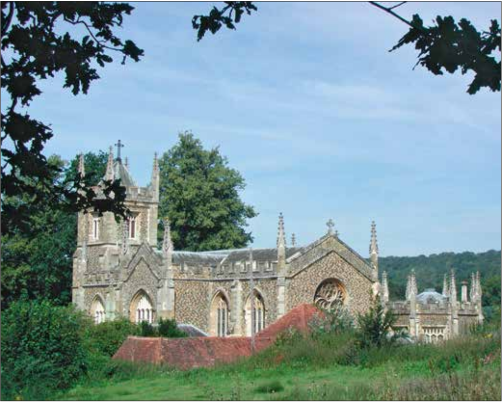
Die Kirche der Apostel in Albury wurde 1840 im englisch-gotischen Stil erbaut.
